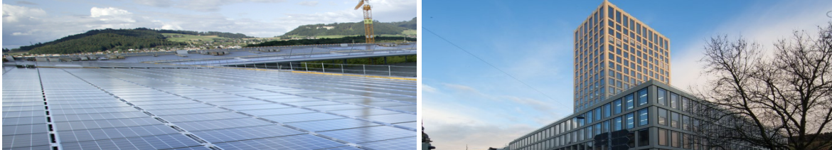
Bild: Stadion-Solarkraftwerk auf dem Stadion Wankdorf ‚Stade de Suisse‘ in Bern; Fachhochschule St. Gallen
